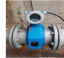
Hình 3.1: Đồng hồ đo lưu lượng theo nguyên lý điện từ Endress Hauser
