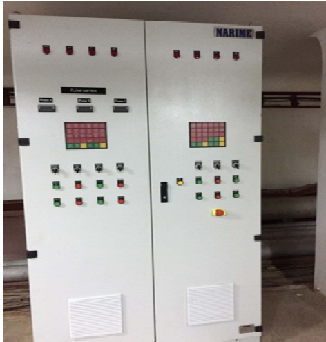
Tủ làm mát máy biến áp
