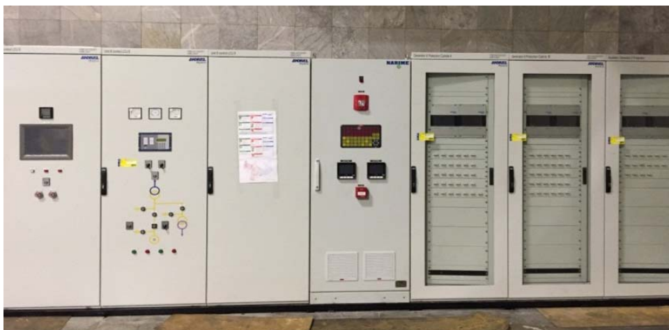
Tủ giám sát nhiệt độ trực tuyến và cảnh báo cho tổ máy phát điện
