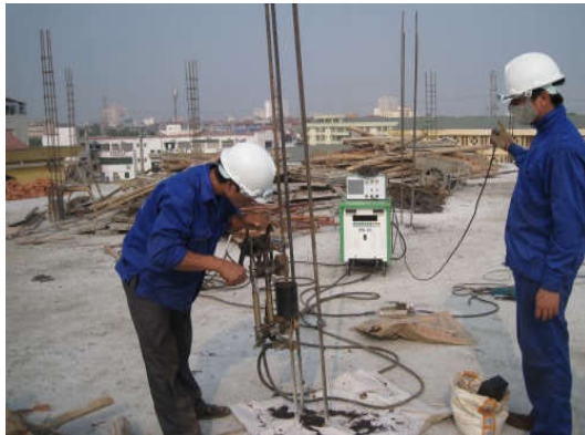
Hình 1.1. Hàn điện xỉ - áp lực
