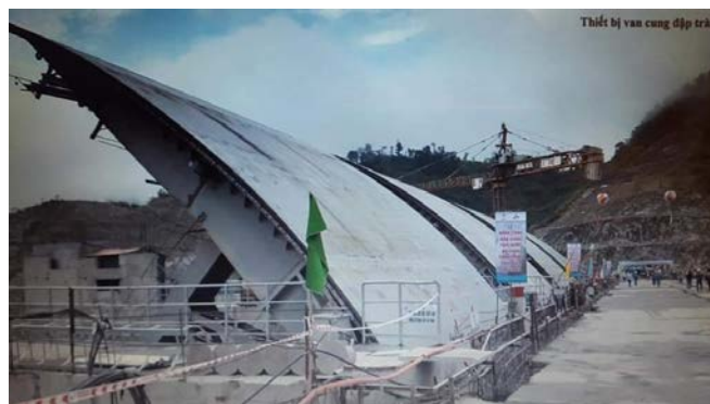
Hình 4. Hình ảnh vận hành thử nghiệm (khô) van cung xả mặt
