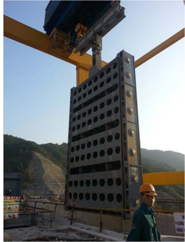
Hình 6. Hình ảnh cửa van sửa chữa sự cố
