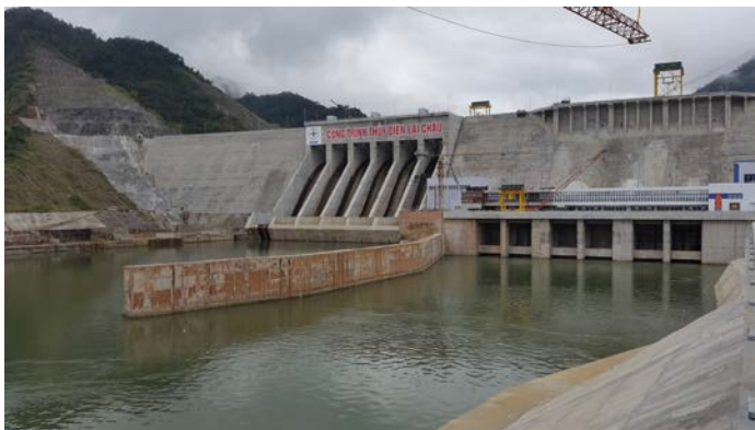
Hình 2. Hạ lưu nhà máy thủy điện Lai Châu
