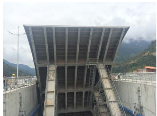
Hình 3. Hình ảnh cửa van cung tràn xả mặt
