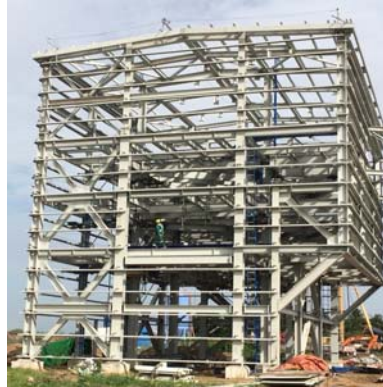
Hình 1: Thiết kế tháp chuyển tiếp bằng Tekla và hình ảnh thực tế lắp đặt tại công trường
